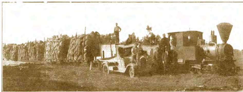
"Decauville", propiedad de la S. A. La Chaqueña, transportando algodón.
